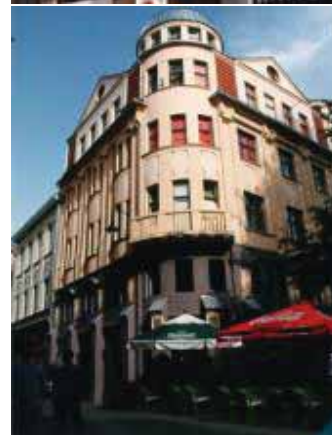
stanovanjsko- poslovna stavba Mejerja Altraca 1911 geometrijski nouveau
