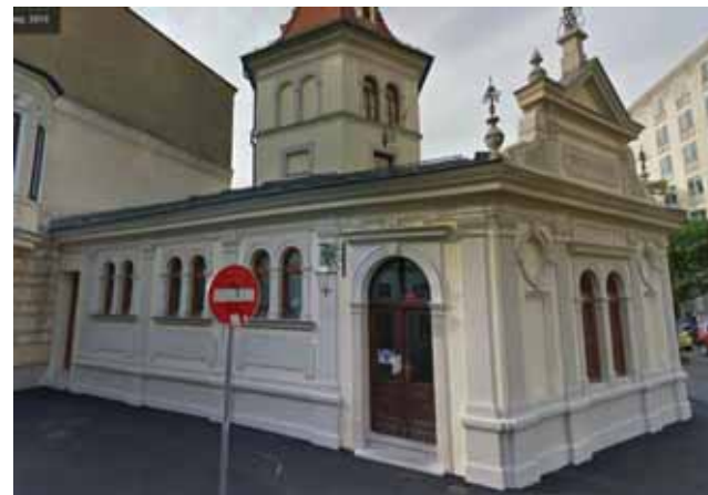
Ljudska kopel 1899-1901 Avtor: Wilhelm Bruckner & Co iz Gradca Izvajalci: Adolf Tonnies - gradbena dela, E. Ast & Co - betonske konstrukcije, W. Bruckner iz Gradca - instalacije
